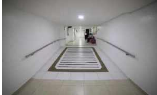
Figura 252. Rampa Segundo Piso Bloque C.
