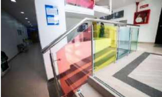
Figura 249. Instalación Pasamanos Bloque F.
