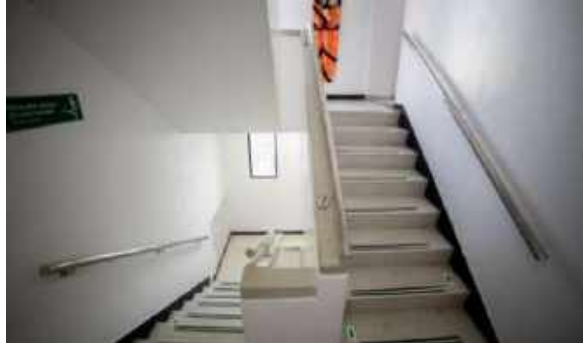
Figura 250. Instalación Pasamanos Bloque E.
