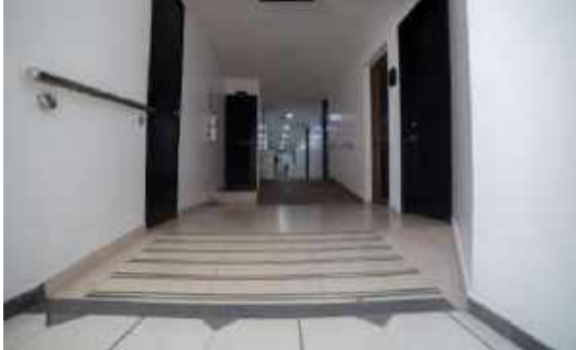
Figura 251. Rampa Tercer Piso Bloque C.
