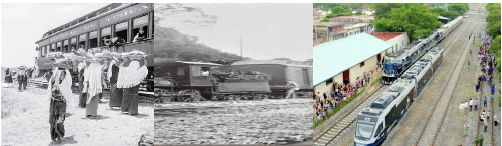
Figura 2. Imágenes comparativas del Ferrocarril del Istmo de Tehuantepec y del ferrocarril del Corredor Interoceánico del Istmo de Tehuantepec
